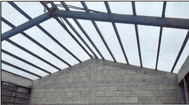
Momento en que destechan el edificio de dos aulas.
