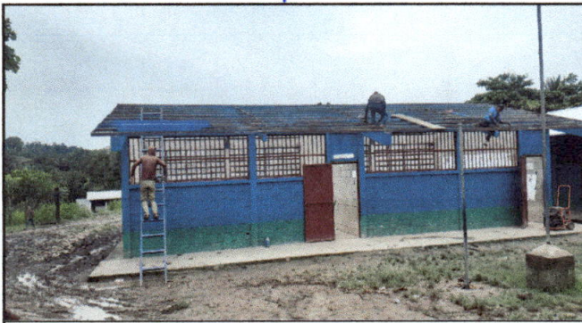
Realizando el mantenimiento de estructuras metálicas de un edificio de dos aulas
