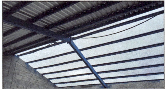
Colocación de techos nuevos de las dos aulas.
