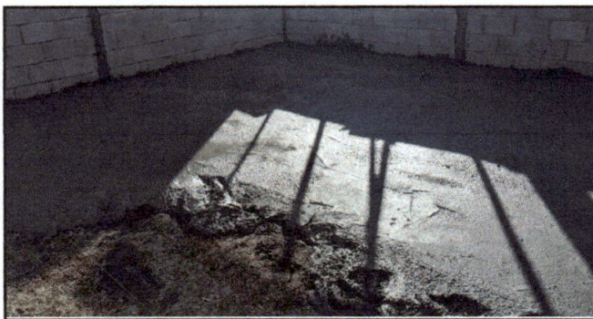
Fundición del piso de un aula.
