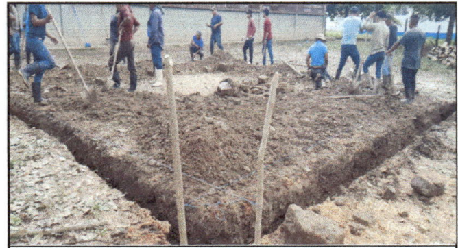
Colocando las bases para instalar el piso de un edificio de un aula.
